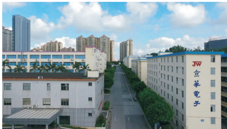
占地15万平方米京华智能产业科技园
